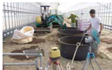
建設中のシモダファーム(2019年8月)
